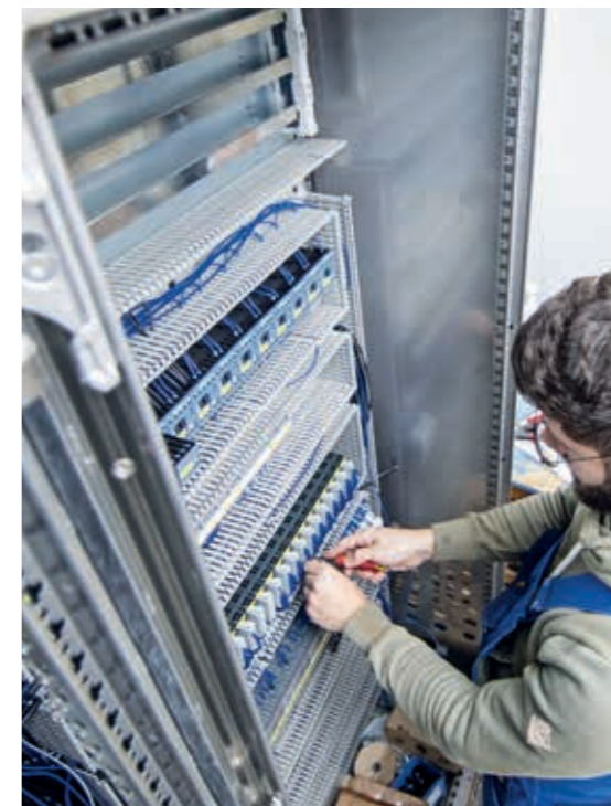
AUFWENDIG: Kassem Al Mahmoud baut für ein Hohenlimburger Kaltwalzwerk die Schaltschranke neu auf.
